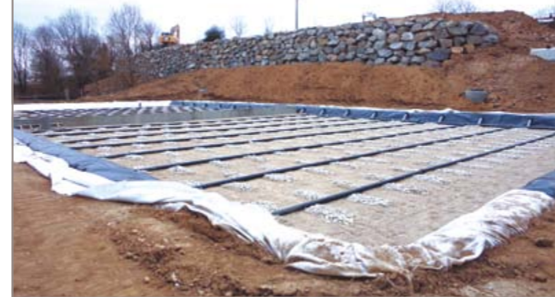
Second étage de filtration constitué de 2 casiers.
