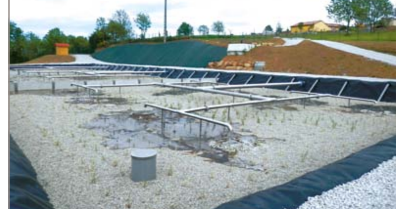
Second étage de filtration constitué de 2 casiers.
